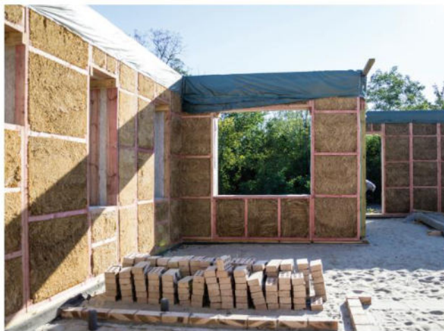
Bau eines Hauses aus umweltfreundlichen, pflanzlichen Materialien: Der Rahmen besteht aus Holz und ist gefüllt mit Strohblöcken. Foto: Shutterstock
