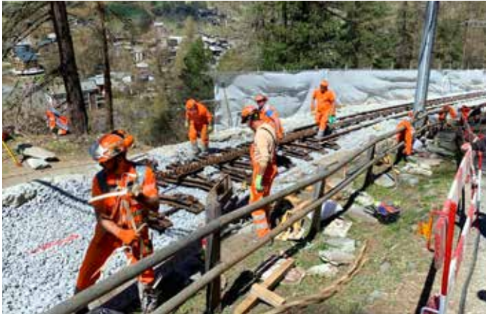
Fahrbahnerneuerung bei Findelbach im April 2020
