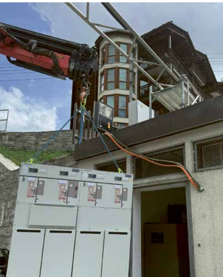
Die Modernisierung bestehender Anlagen ist ein wichtiger Punkt in der Versorgungssicherheit. Im Bild ist der Austausch einer Mittelspannungs-Schaltanlage im 20kV-Netz zu sehen.
