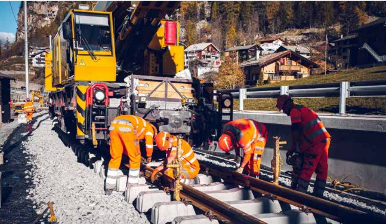
Bauarbeiten bei Mattsand im Jahr 2022
